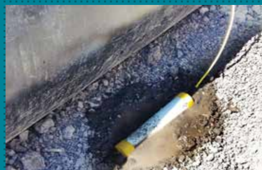
Монтаж электрода сравнения
