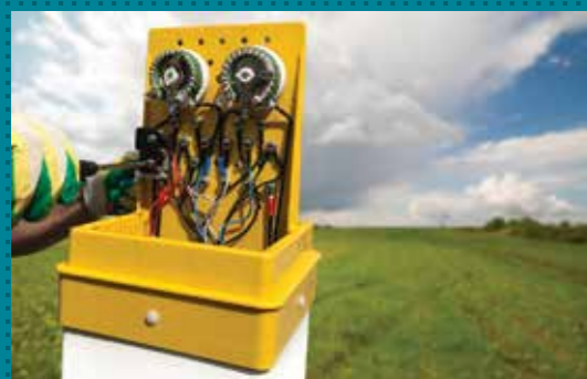
Монтаж кабелей на клеммной панели
