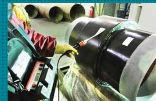
Проверка диэлектрической сплошности наружного покрытия
