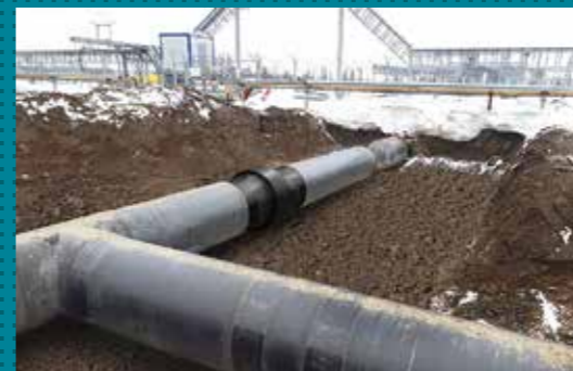
Установка изолирующей монолитной муфты диаметром 1420 мм на газопроводе
