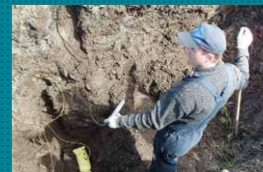
Монтаж ПКМ-ТСТ-КонтКорр®
